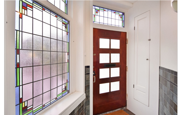
Grondgebonden woningen meterkast
